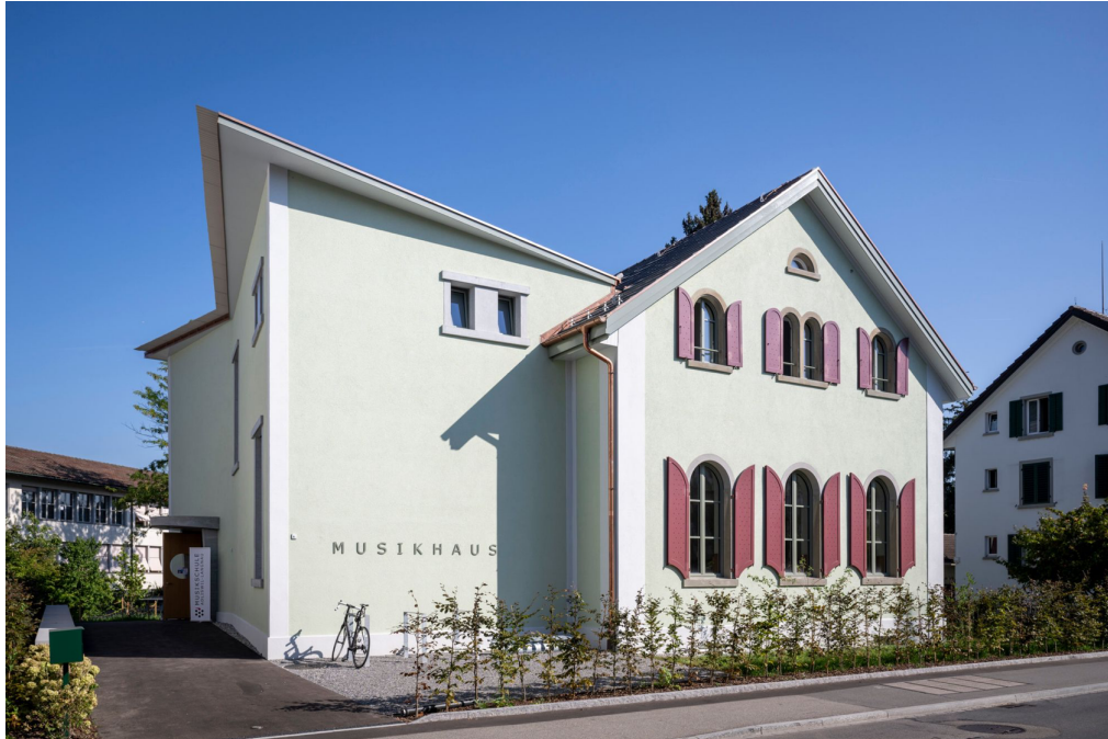
Pastellfarbene Fassade und markante Fensterläden: Das frisch sanierte Gebäude fällt auf.
