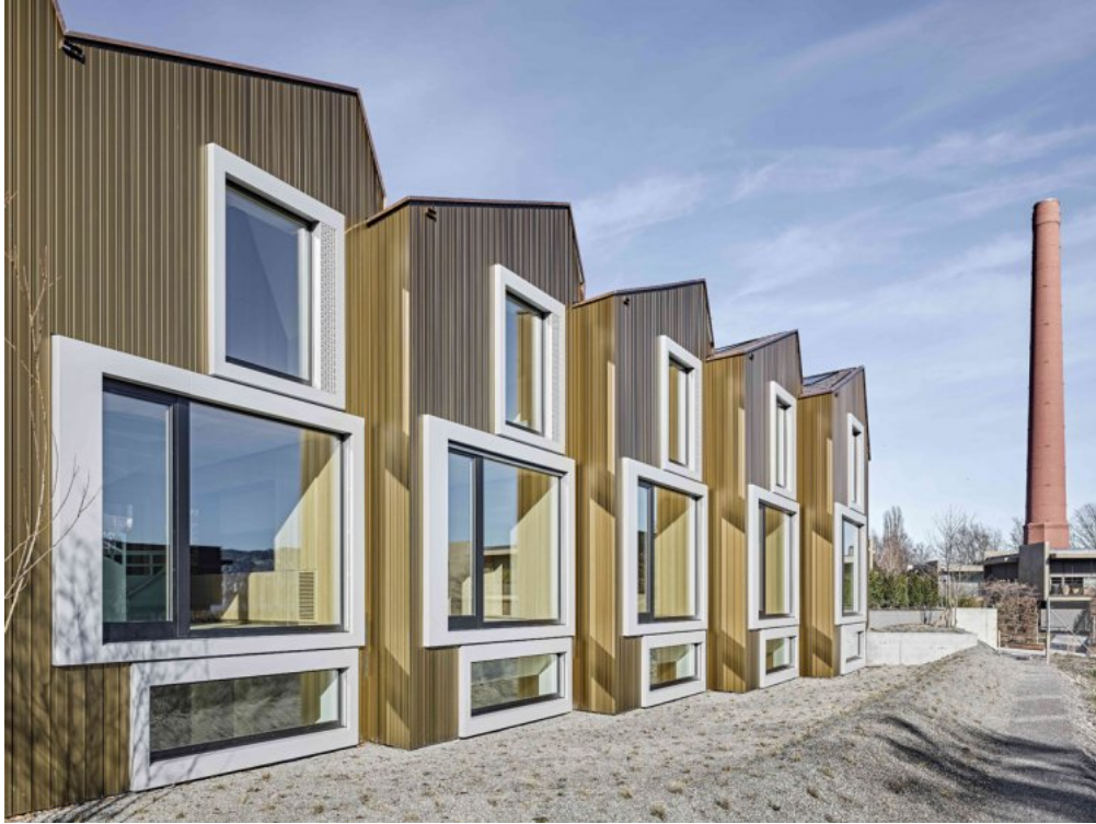
Der alte Kamin ist eine Reminiszenz an die Papierfabrik, die sich einst auf dem Grundstück befand, die bronzefarbene Fassade reflektiert das abendliche Licht des Sees. Bild: Roger Frei, Zürich
