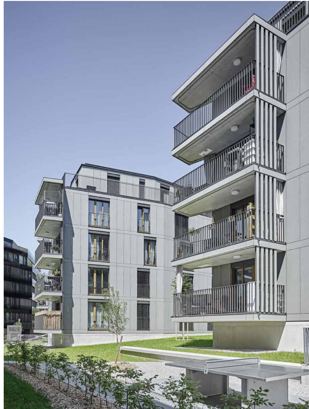
Der Grundriss wurde auf die Masse der Fassadenplatten abgestimmt, um einen Verschnitt zu vermeiden.
