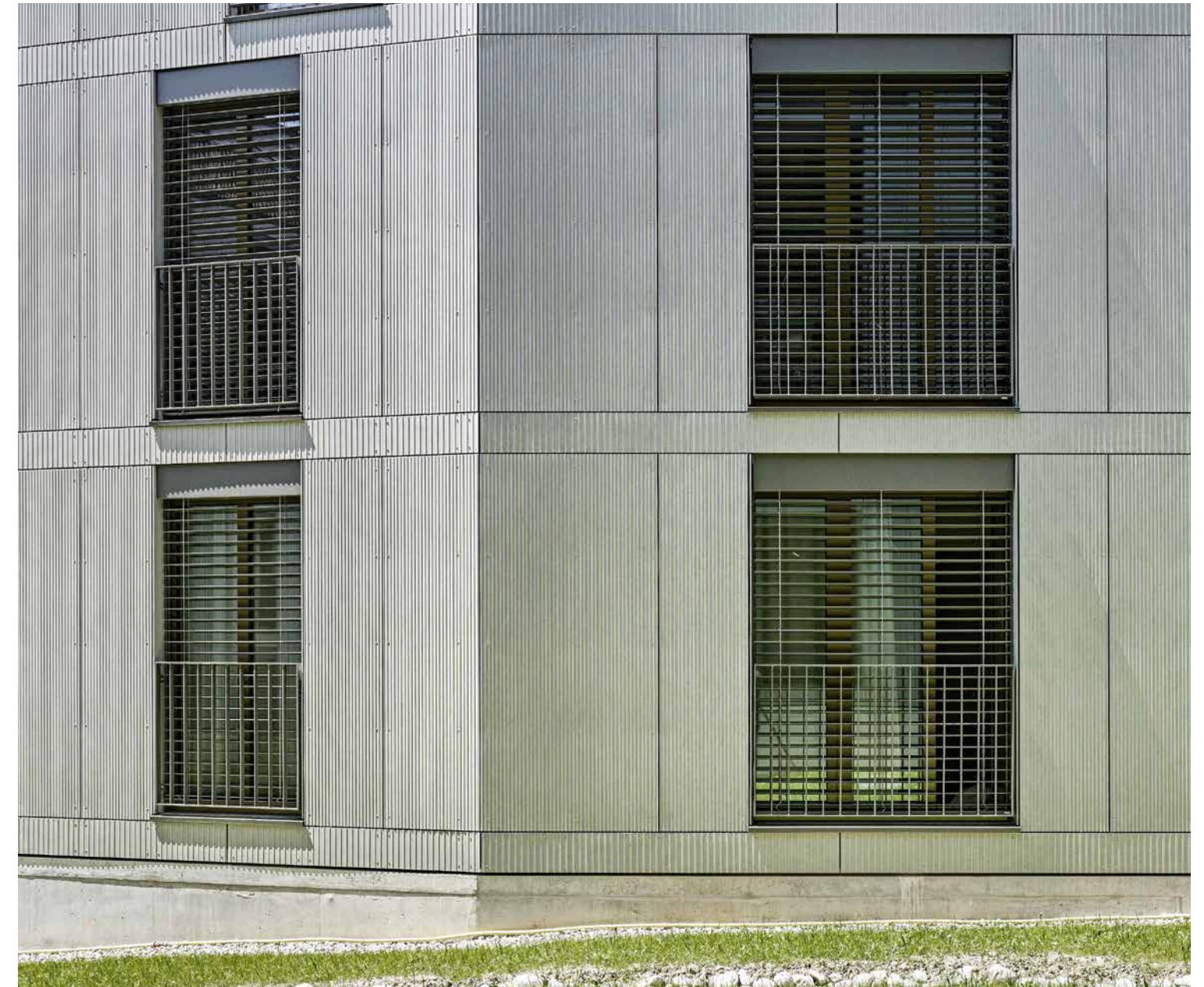
In diese Faserzementafeln wurden zwei Millimeter tiefe Rillen gefräst. Das erzeugt eine sehr feine Textur wie bei einem Nadelstreifenanzug.
