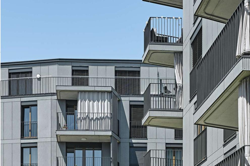
*Ausragende Betonbalkone mit Stoffvorhängen als Sicht- und Sonnenschutz erweitern die Wohnräume nach aussen.*
