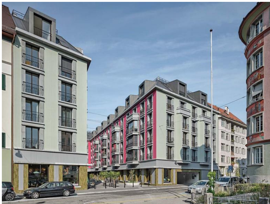
Ansicht von der Verzweigung Sihlfeld-/Ernastrasse mit neuer Gasse. Bild: Roger Frei
