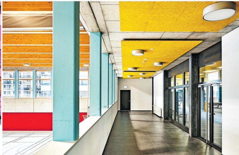
Turnhalle und Decke mit gelben Heraklith-Dämmplatten
