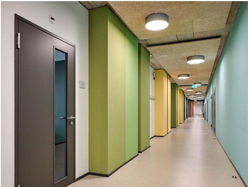
Das Lüftungskonzept maximiert die lichte Raumhöhe in den Klassenzimmern. Die Versorgung erfolgt über vertikale Stränge in den langen Korridoren und nicht über eine abgehängte Decke in den Schulzimmern. Bild: Roger Frei
